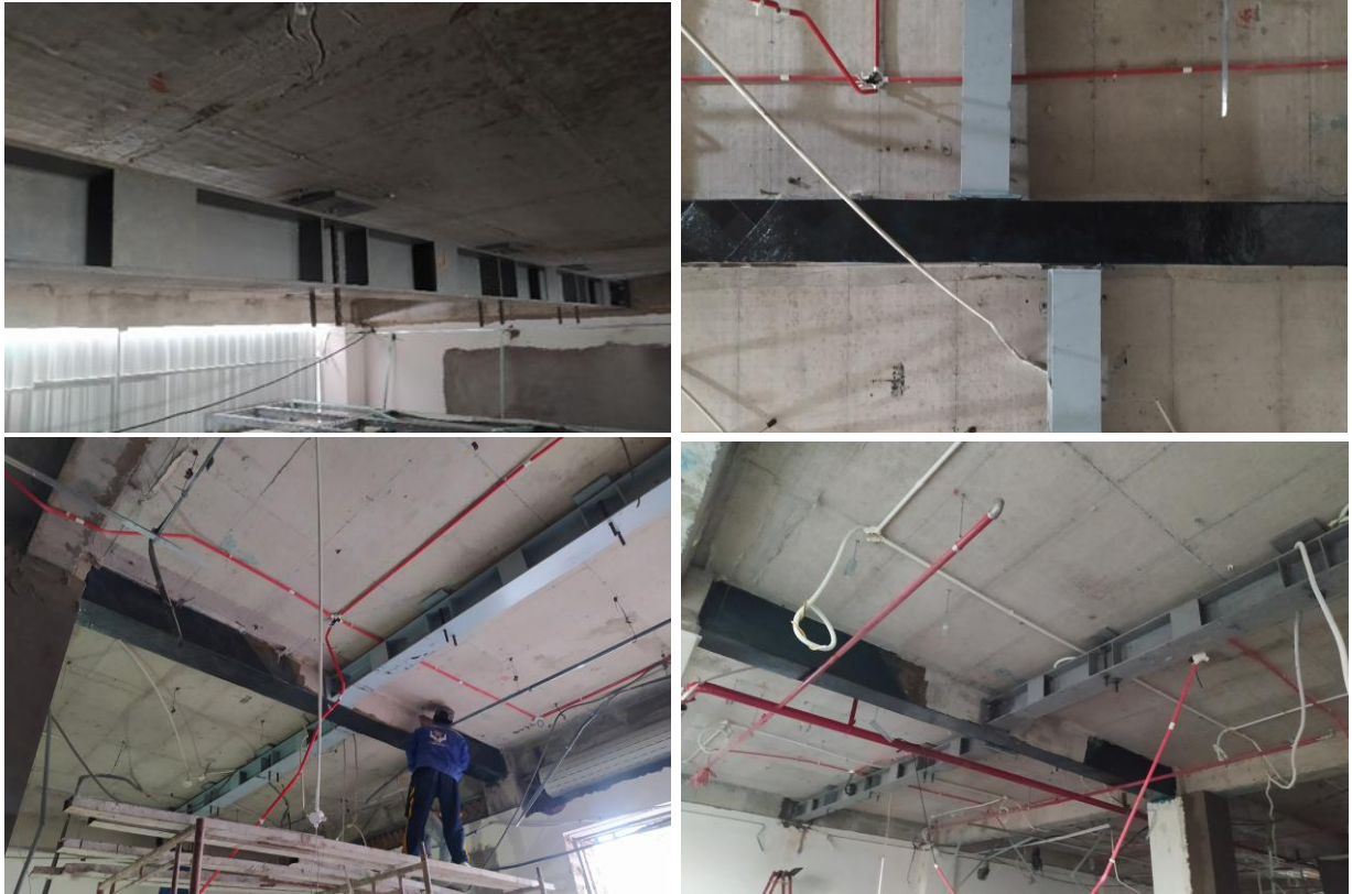
Thi công gia cố dầm thép.
